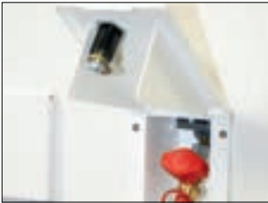
Gasanschluss aussen
